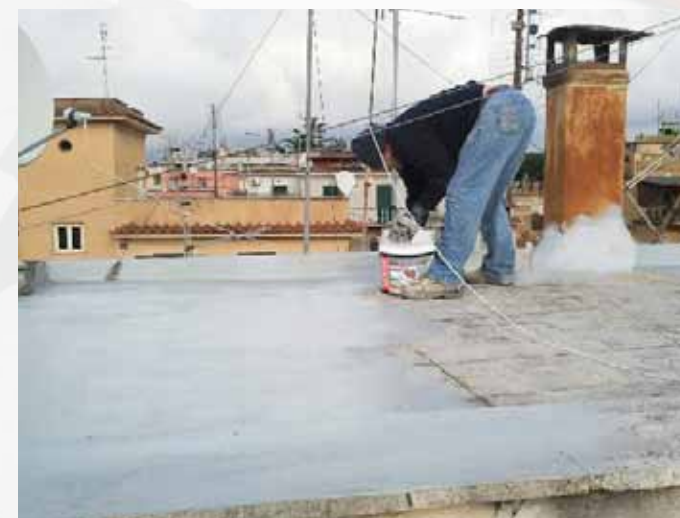
Impermeabilizzazione vecchie coperture
