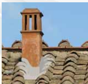
Impermeabilizzazione intersezioni tra comignoli e tetti
