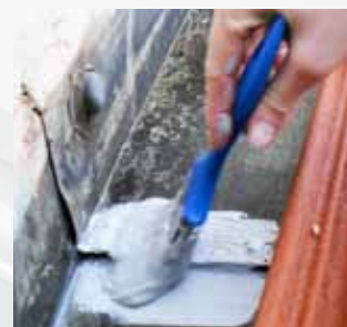
Sigillatura impermeabile di elementi in lamiera
